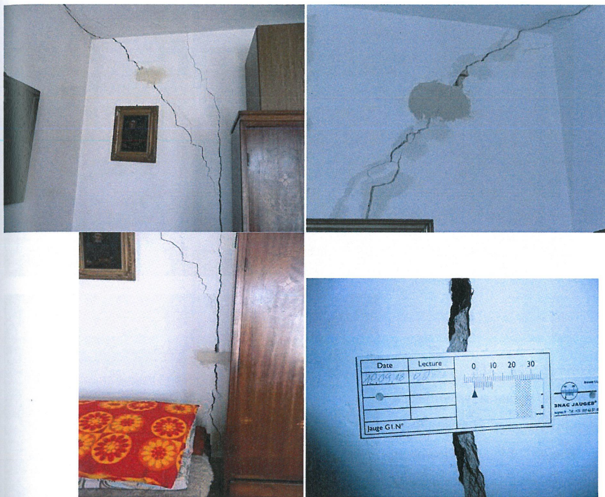
Fot. 25, 26, 27, 28 Pęknięta ściana podłużna w lokalu na parterze. Założono miernik przyrostu szerokości szczeliny.
