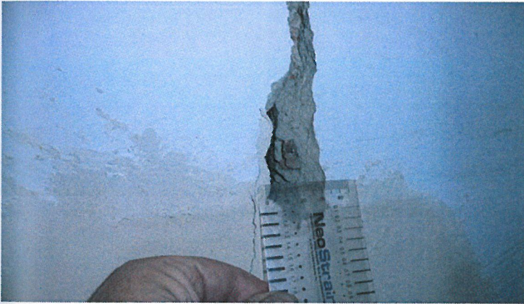
Fot. 32, 33, 34 Szerokość szczeliny w ścianie środkowej na parterze i rysy w plombie gipsowej po 12 dniach od założenia.
