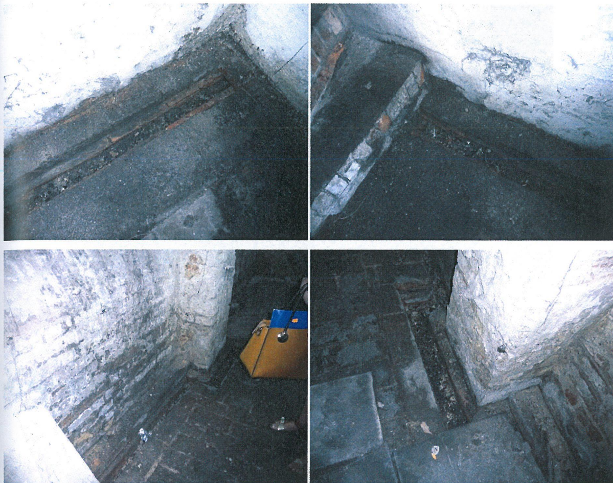
Fot. 44, 45, 46, 47 Rowki wymurowane w podłogach piwnic wzdłuż ścian zewnętrznych, służące do odprowadzenia wody podchodzącej z gruntu.
